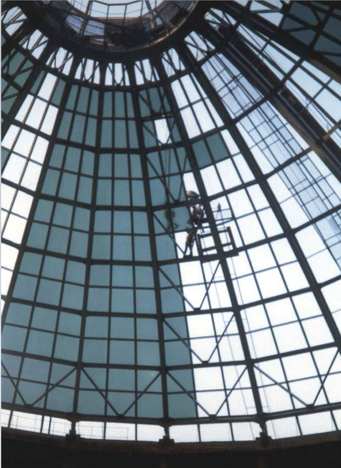
Dome skylight montajından görünüm.
